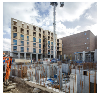
Imagen 4.8 Construcción de cimentación y PB en hormigón. - https://www.theb1m.com/video/dalston-lane-the-worlds-largest-timber-building
