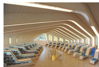
Imagen 1.4 Biblioteca construida enteramente de mass timber. - https://vilssa.com/madera-laminada-encolada-estructural
