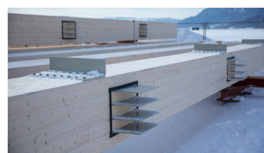
Imagen 3.34 Vigas con placas de anclaje predispuestas. - https://maderayconstruccion.com/torre-mjostarnet-noruega-arquitecturademadera/
