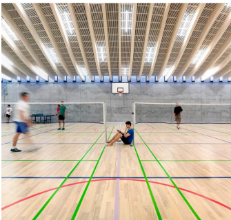
Imagen 1.11 Vista interior del gimnasio con vigas de Glulam. - https://big.dk/#projects-ghg
