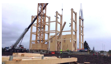
Imagen 3.33 Montaje in situ de la estructura. - https://maderayconstruccion.com/torre-mjostarnet-noruega-arquitecturademadera/
