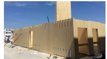
Imagen 4.23 Panel de planta primera con mecanizado para anclajes. - https://www.binderholz.com/en-us/mass-timber-solutions/dalston-lane-london-great-britain/
