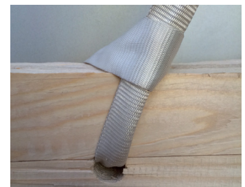
Imagen 2.37 Lazo de elevación. - Directiva de procesamiento binderholz CLT bbs
