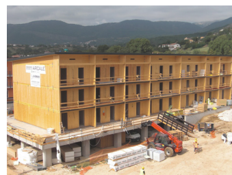
Imagen 2.7 Estructura completa, edificio Aquila. - https://www.sistem.it/es/realizaciones/edificios-residenciales/bloques-viviendas-de-varios-pisos-y-viviendas-sociales/proyecto-c-a-s-e-laquila/
