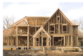
Imagen 1.3 Vivienda construida empleando el balloon frame. - https://buildsmatr.com/products/wood-or-steel-framing
