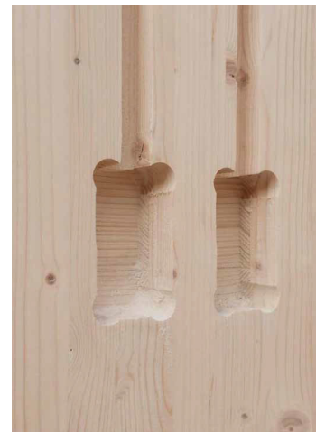
Imagen 2.94 Perforaciones para instalaciones eléctricas. - Forté – Building, australias first timber Highrise, Lend Lease and WoodWorks
