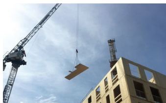
Imagen 4.33 Elevación de panel con grúa. - https://www.binderholz.com/en-us/mass-timber-solutions/dalston-lane-london-great-britain/
