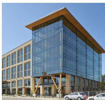
Imagen 1.21 Vista exterior del edificio. - https://www.lakeflato.com/developmentcommercial/soto-building/?project=open
