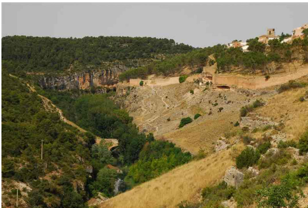
Figura 33. Vista del río Júcar y puente del Picazo (SIA Júcar)
