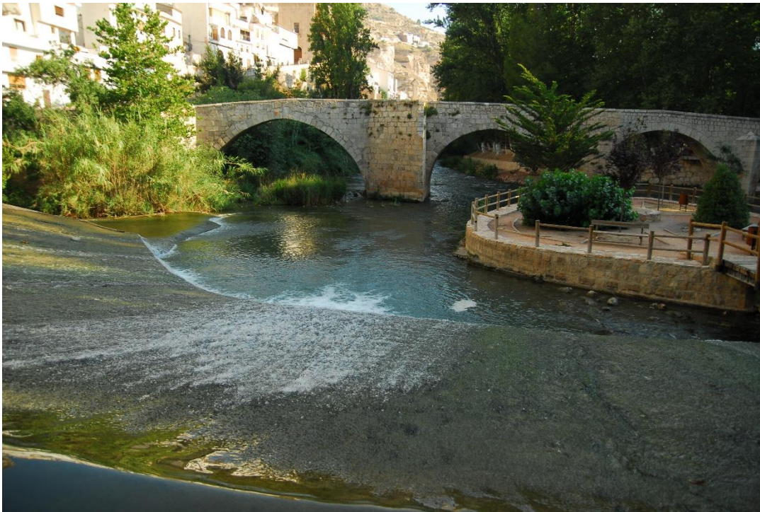
Figura 1. Puente y azud en el río Júcar en Alcalá del Júcar (GeshidroLAN, 15/Jul/2009)
