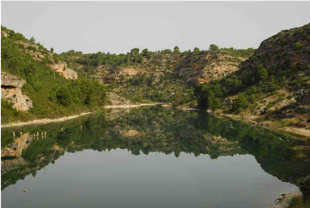
Figura 30. Vista desde la presa del Henchidero en el río Júcar aguas abajo de Alarcón (SIA Júcar)
