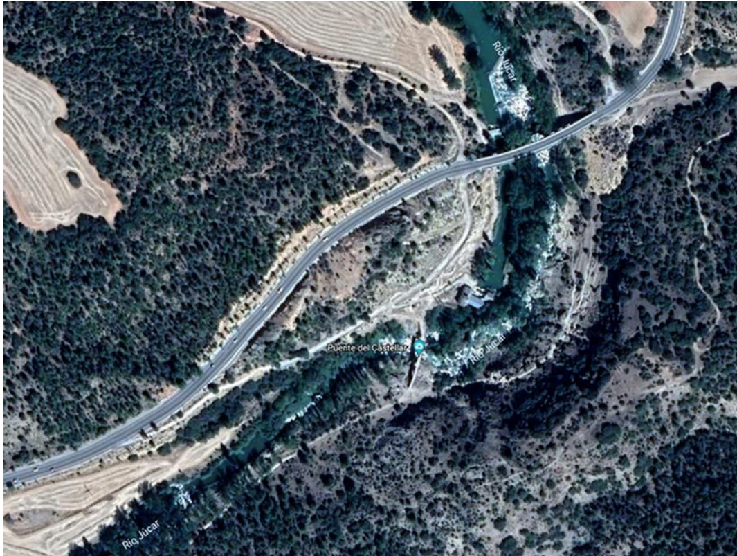
Figura 76. Ortofoto río Júcar a su paso por azud El Castellar (Google Earth)
