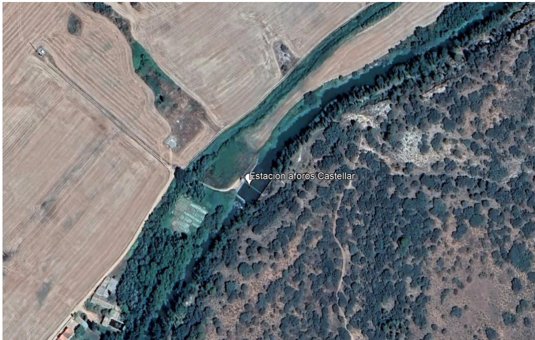
Figura 86. Estación de aforos ROEA 8091 El Castellar (Google Earth)
