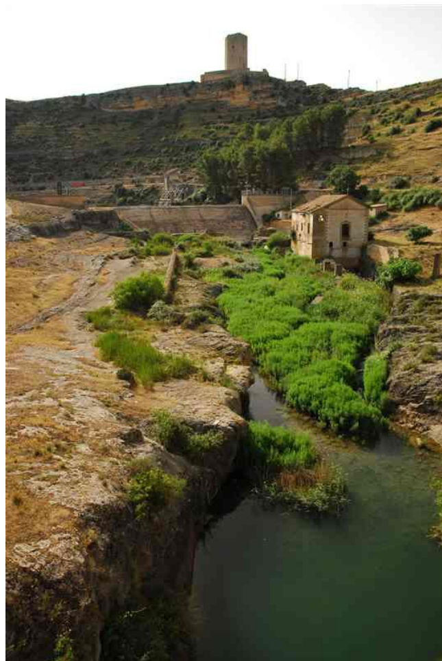
Figura 31. Vista de la presa del Henchideras desde el puente de Tebar (SIA Júcar)
