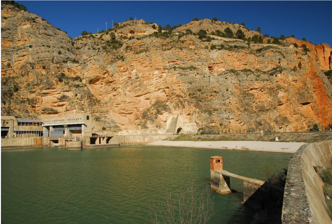
Figura 52. Presa de El Molinar en el río Júcar en Villa de Ves (GeshidroLAN, 9/Abr/2010)
