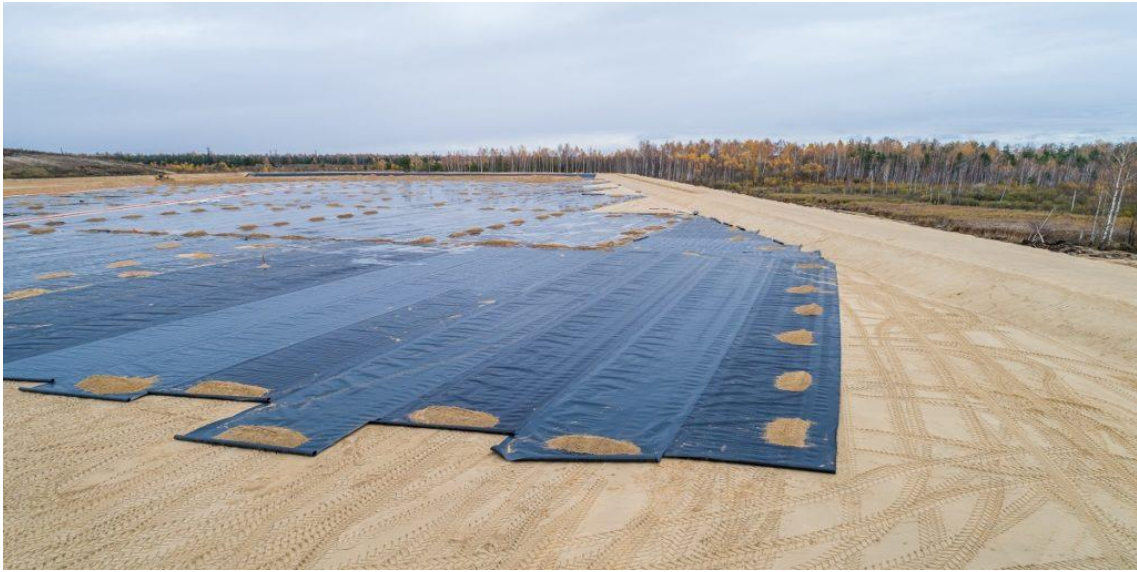
Ilustración 12. Revestimiento de un vertedero con arcillas de antracita-bentonita. Fuente: mineralmilling.com.
