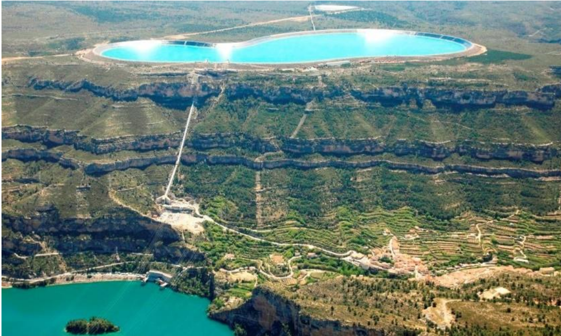
Ilustración 4. Complejo de Cortes La-Muela. Fuente: Iberdrola.
