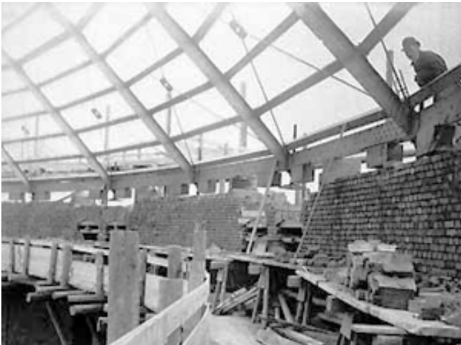
Figura 105_ Construcción de cúpula en unos de los Gasómetros. Recuperado de: http://www.gasometer-city.eu/geschichte.htm
