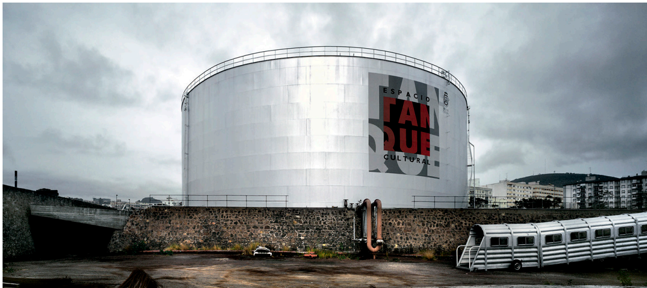
Figura 134_ El tanque Tenerife.
