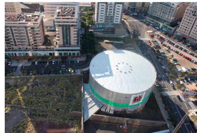
Figura 140 _ "El Tanque" y zonas adyacentes, estado actual
