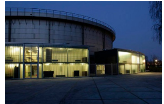
Figura 155_ Estado actual del exterior del gasómetro, con las extensiones de vidrio añadidas en la rehabilitación.
