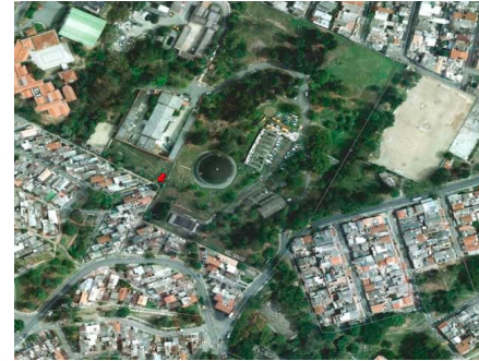
Figura 76_ Estado antiguo UVA el Encanto Fuente: Google Maps.
