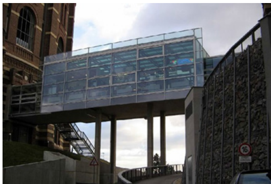
Figura 112 Zoom de pasarela que conectan los gasómetros. Fuente: https://en.wikiarquitectura.com/building/gasometer/
