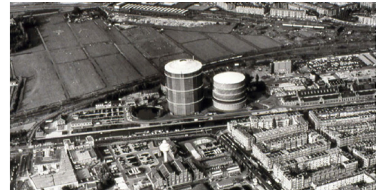
Figura 147_ Área industrial 'Westergasfabriek', de los 5 gasómetros que existieron en la zona: a la izquierda el tan-que de un gasómetro demolido, en el centro un gasómetro de pistón, a la derecha un gasómetro de guías espirales. Posteriormente se construiría a la derecha de éste otro más. Detrás, el gasómetro telescópico conservado.
