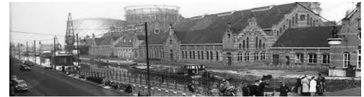
Figura 146_ Área industrial 'Westergasfabriek', donde se aprecian al fondo un gasómetro de guías espirales y el gasómetro telescópico como caso de estudio. Fuente: Hernández, I. (2018). Gasómetros, historia y reciclaje de una tipología industrial en Europa .
