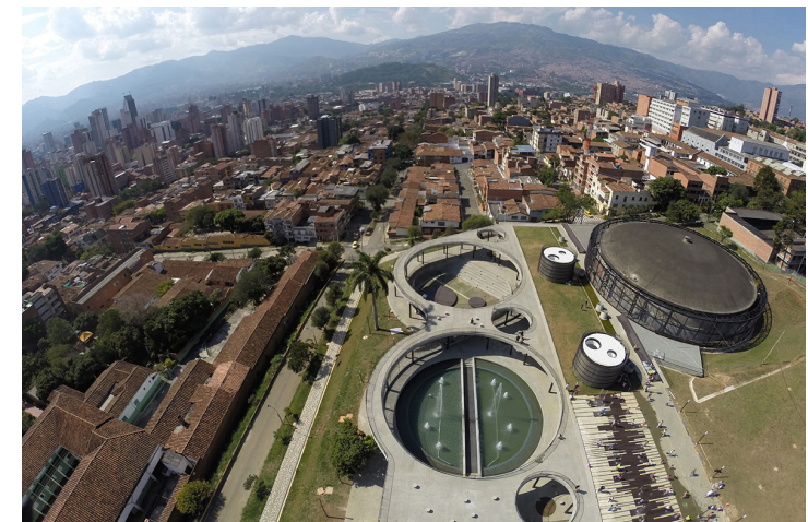
Figura 163_ Interior del gasómetro tras la rehabilitación. Recuperado de: https://www.arquine.com/uva-la-imaginacion/
