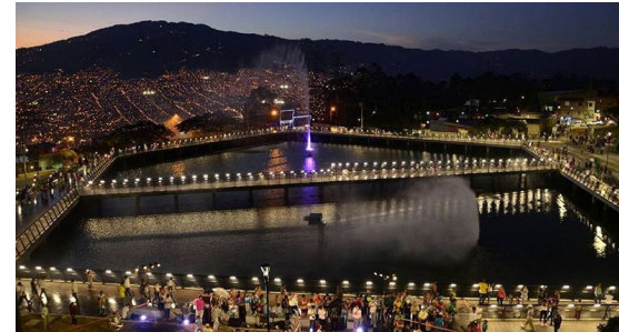
Figura 61_ Estado actual UVA de la Armonía
