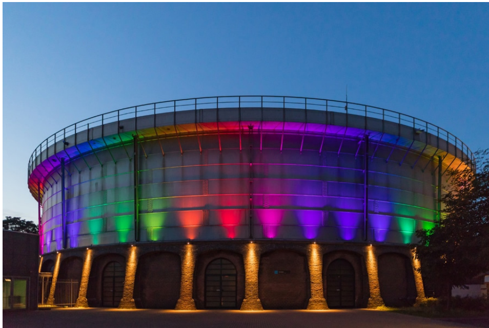
Figura 154_ Estado actual del tanque, iluminación exterior.
