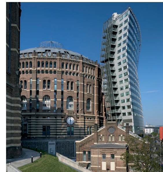
Figura 115_Gasómetro B vista exterior. Fuente: Hernández, I. (2018). Gasómetros, historia y reciclaje de una tipología industrial en Europa. Trabajo Final de Grado. Madrid, Universidad Politécnica de Madrid.
