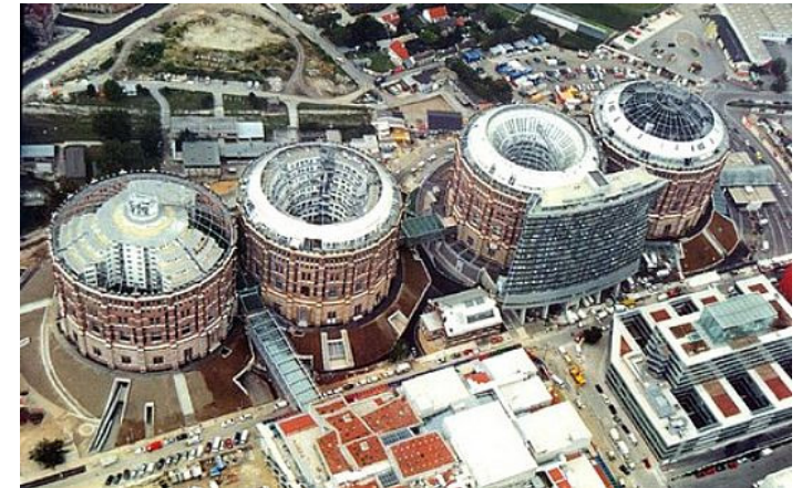
Figura 103_Los 4 gasómetros rehabilitados. GASOMETROS :
