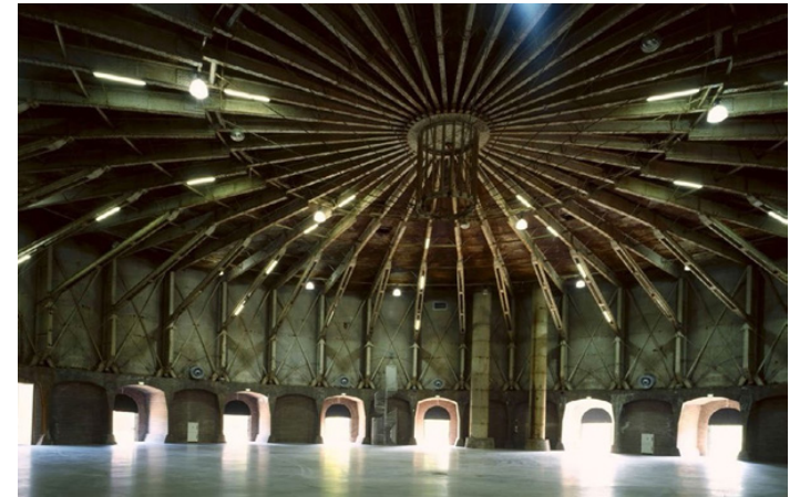
Figura 159_ Interior del gasómetro tras la rehabilitación. Fuente: Hernández, I. (2018). Gasómetros, historia y reciclaje de una tipología industrial en Europa.
