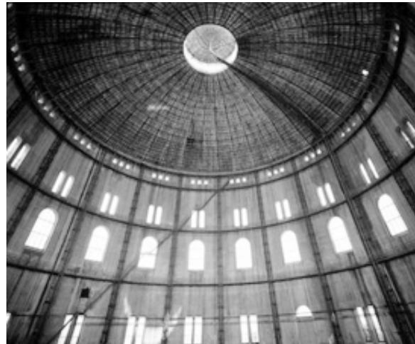
Figura 106_ Interior de uno de los gasómetros con envoltente de ladrillo. Recuperado de: http://www.gasometer-city.eu/geschichte.htm
