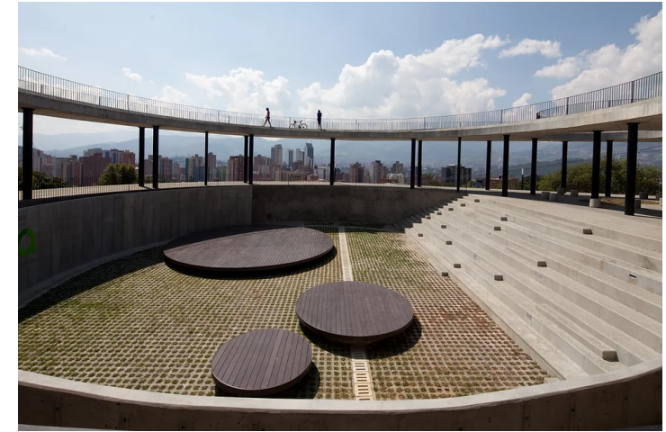
Figura 172_ Levantamiento del tanque del Orfanato.
