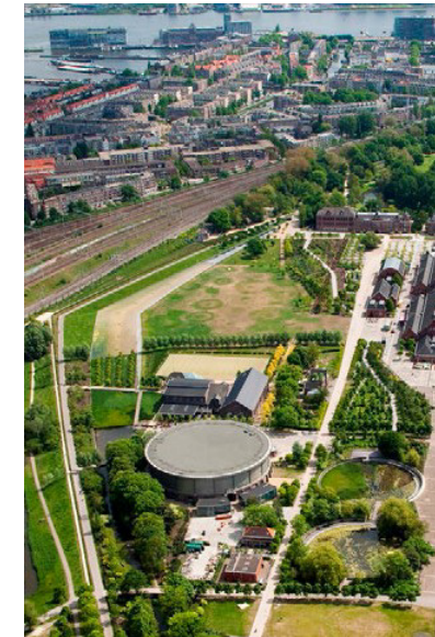
Figura 152_ Estado actual del tanque y el parque. Fuente: Hernández, I. (2018). Gasómetros, historia y reciclaje de una tipología industrial en Europa .
