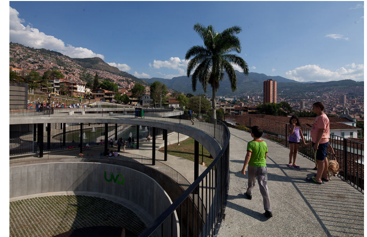
Figura 184_Vista desde cubierta recorrible, el edificio como mirador. Fuente: https://www.arquitecturapanamericana.com/unidad-de-vida-articulada-orfelinato-uva-de-la-imaginacion/
