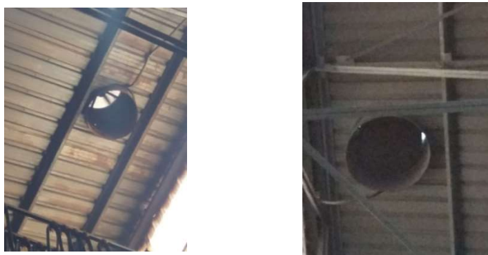
Figura 5. Huecos de ventilación natural existentes en la nave.
