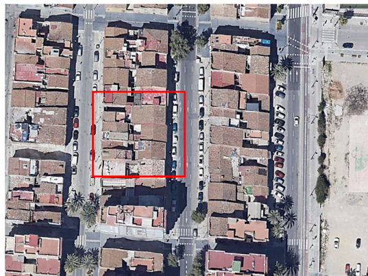
Imagen 1. Vista del barrio y ubicación del edificio objeto del estudio.
