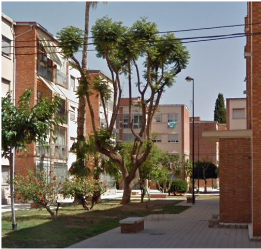
Fig. 55. Tendido en la fachada del grupo Rafalafena, 2021.
