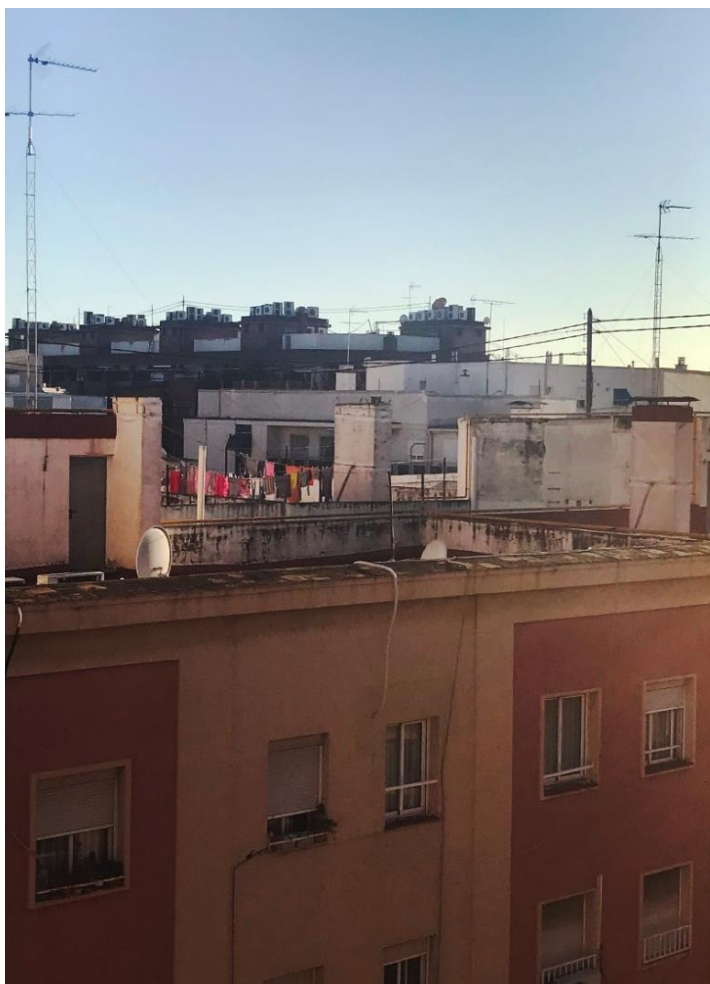
Fig. 63. Cubiertas en Patraix. Fotografía de Rodenas Pina, Lucía. Valencia, 2020.
