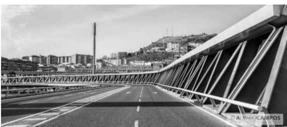
Imagen 15. Calzada y celosía inclinada. Fuente: www.acampos.es
