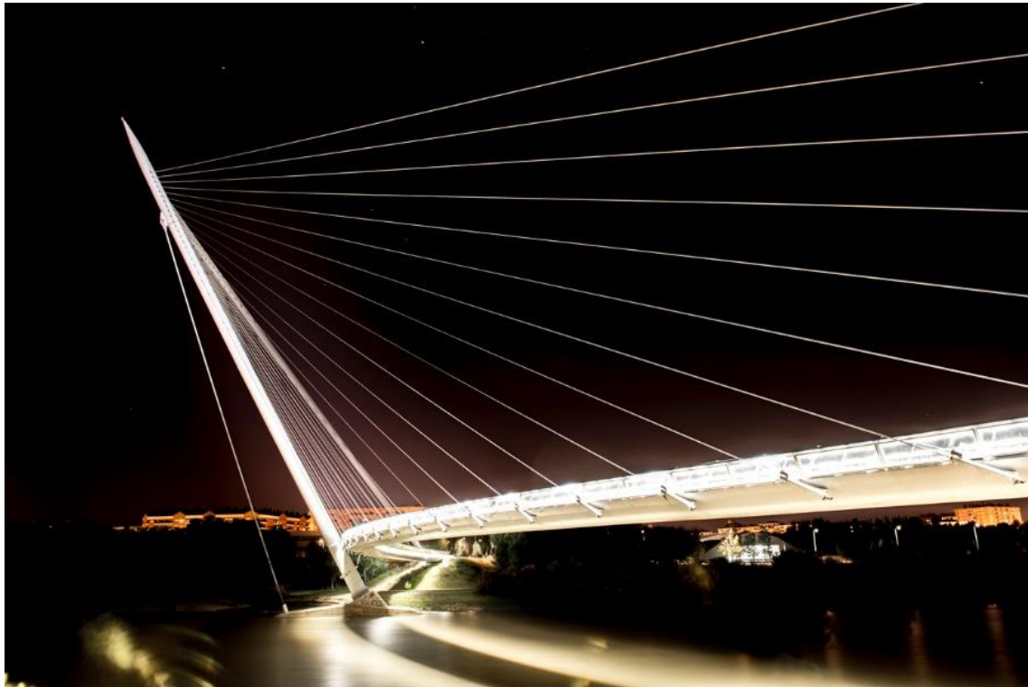
Imagen 34. Iluminación de la Pasarela. Fuente: Oficina de Carlos Fernández Casado S. L. (CFCSL)
