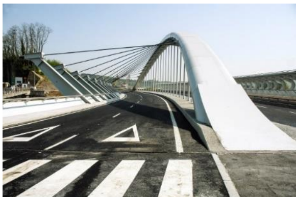
Imagen 29. Parte rodada del puente. Fuente: Oficina de Carlos Fernández Casado S. L. (CFCSL)
