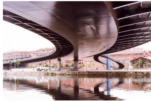
Imagen 11. Parte interior del puente. Fuente: Oficina de Carlos Fernández Casado S. L. (CFCSL)
