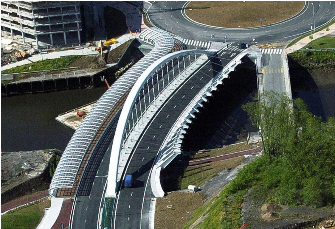
Imagen 24. Puente sobre el Río Galindo. Fuente: Oficina de Carlos Fernández Casado S. L. (CFCSL)
