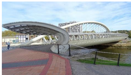
Imagen 7. Puente sobre el Río Galindo. Fuente: sestao.eus (Ayuntamiento de Sestao)
