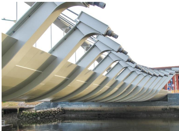
Imagen 26. Vista lateral de los mástiles y tirantes. Fuente: Oficina de Carlos Fernández Casado S. L. (CFCSL)
