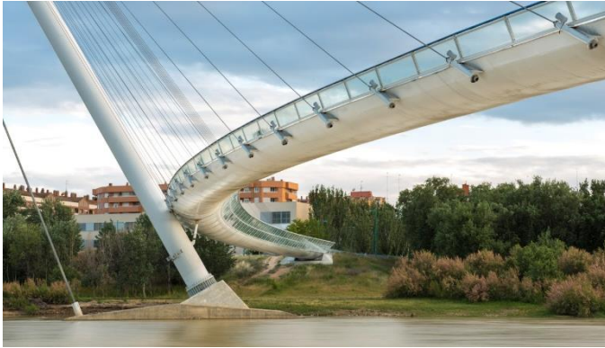
Imagen 31. Vista de la Pasarela. Fuente: Oficina de Carlos Fernández Casado S. L. (CFCSL)
