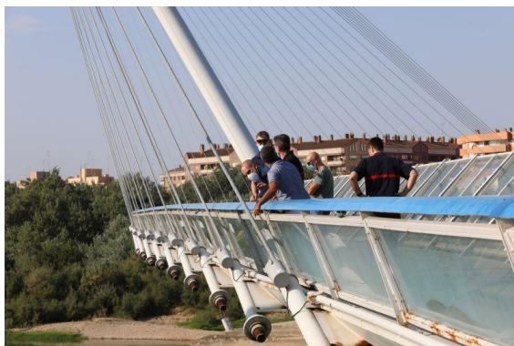
Imagen 37. Profesionales inspeccionando la Pasarela. Fuente: El Periódico de Aragón
