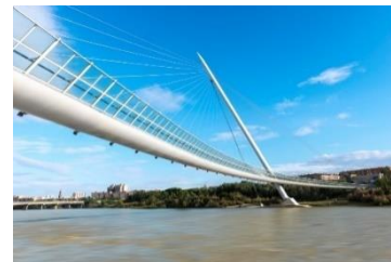
Imagen 8. Pasarela del Voluntariado. Fuente: Oficina de Carlos Fernández Casado S. L. (CFCSL)
