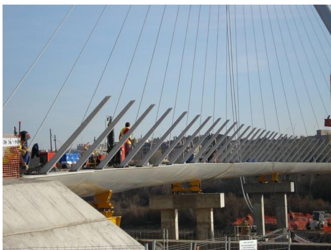
Imagen 32. Construcción de los antepechos. Fuente: rimasa
