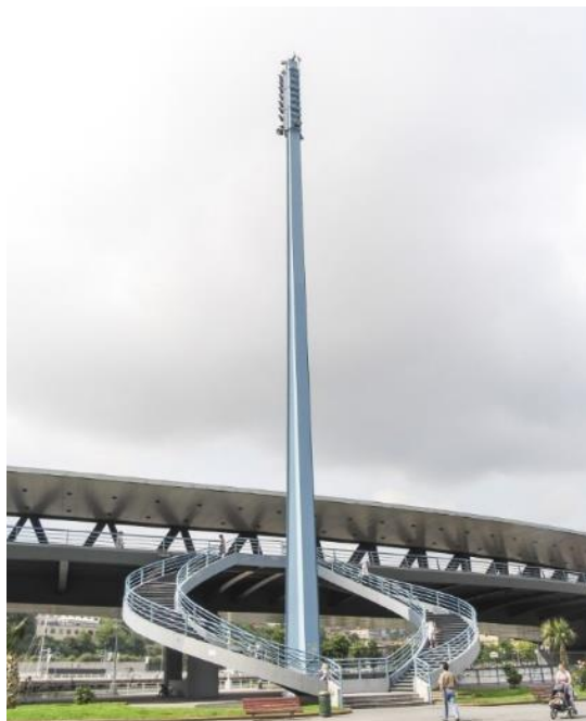
Imagen 12. Escaleras y mástil en la margen de Botica Vieja. Fuente: Oficina de Carlos Fernández Casado S. L. (CFCSL)
