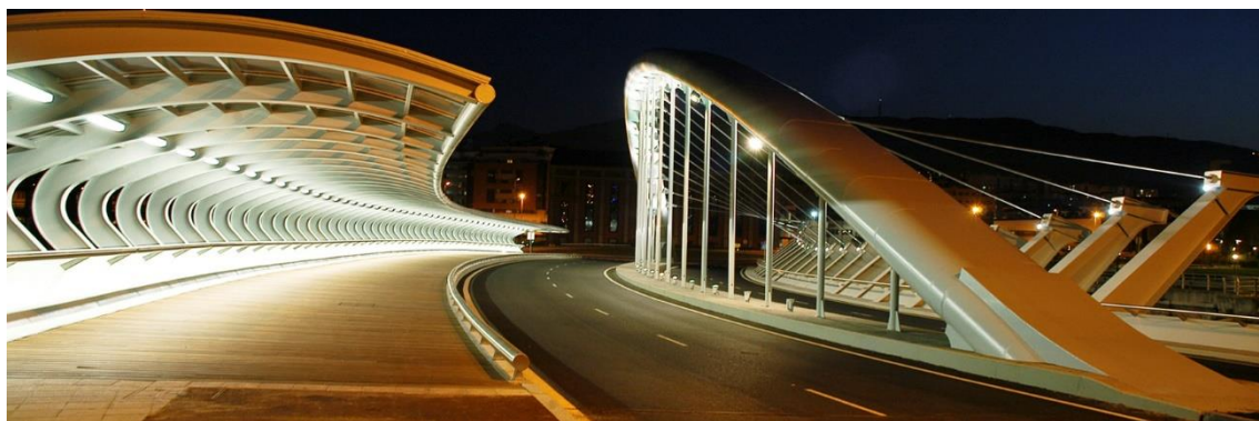
Imagen 27. Iluminación de noche. Fuente: Oficina de Carlos Fernández Casado S. L. (CFCSL)
