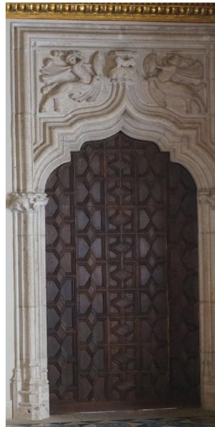
*Ilustración 36. Detalle arco mixtilíneo. Acceso a Salón dorado pequeño.*
