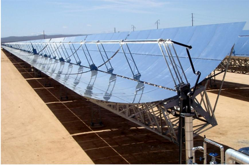
**Figura 2.3 Captador solar térmico de cilindros parabólicos [1]**
