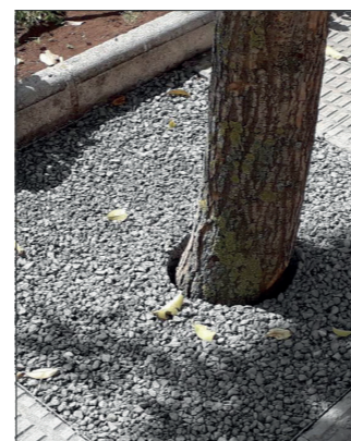
Pavimento de hormigón poroso drenante en las zonas de estancia.
