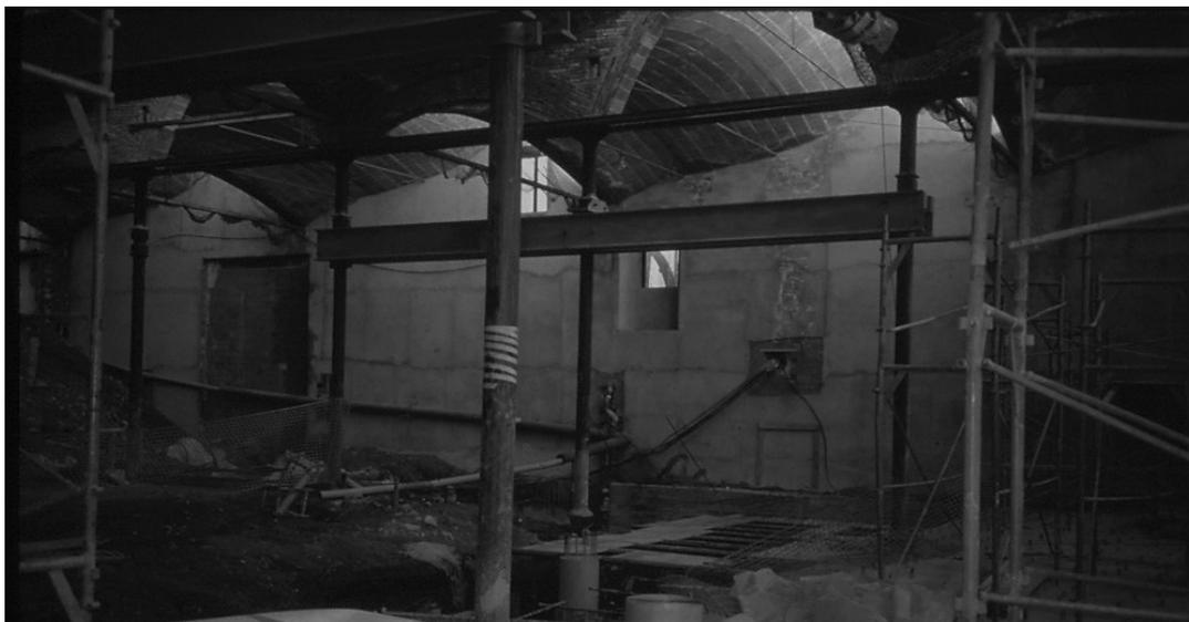
Fig 26 | Proceso de ejecución de la introducción de tubos de PVC en los soportes huecos.
