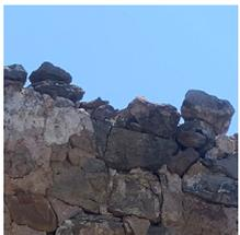
Separación incontrolada de un material manifestándose por simples fisuras, desprendiéndose del acabado, como resultado de la pérdida del sistema de sujeción sumado a acciones exteriores mecánicas.
