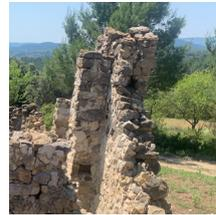
Pérdida de verticalidad por rotación al producirse un giro respecto al eje vertical por falta de arriostramiento.
