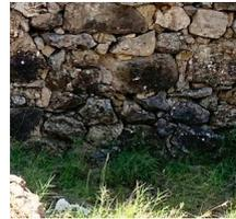
Se produce por la ascensión del agua del terreno a través de la fábrica en contacto con el mismo. Se manifiesta debido a una presencia previa de humedad en el terreno y en dependencia de la porosidad y aidez de agua del material pétreo.
