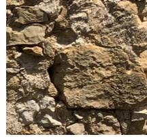
La acción del viento y las partículas que este contiene desgastan la piedra. Así como el agua de lluvia que puede provocar lavados, deslizando por la fábrica las partículas de los depósitos de suciedad superficiales, penetrando en la porosidad de la roca, y comenzando a desgastarla.
