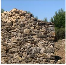
Junta erosionada por agentes atmosféricos, entre ellos la lluvia y el arrastre de agua provocan el lavado y la merma del material. El aumento del volumen de agua congelada provoca el estallido del agua absorbida en la junta produciéndose finalmente un vaciado del material.
