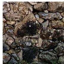
Depósito superficial alojado en la capa exterior de la piedra, producto de la contaminación, derivados del carbón y otras partículas que accionan junto a la humedad produciendo esta capa fina de color oscuro.
