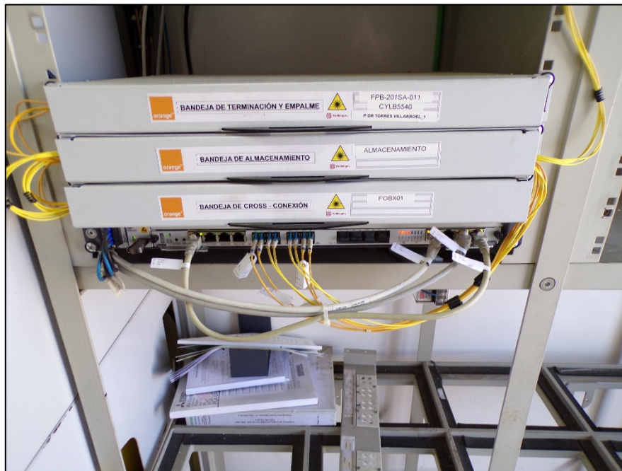
Imagen 19. PTN y repartidores de fibra. Elaboración propia.
