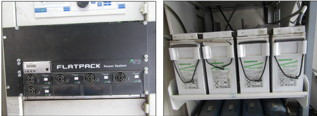
Imagen 20. Equipo de fuerza y baterías. Elaboración propia.
