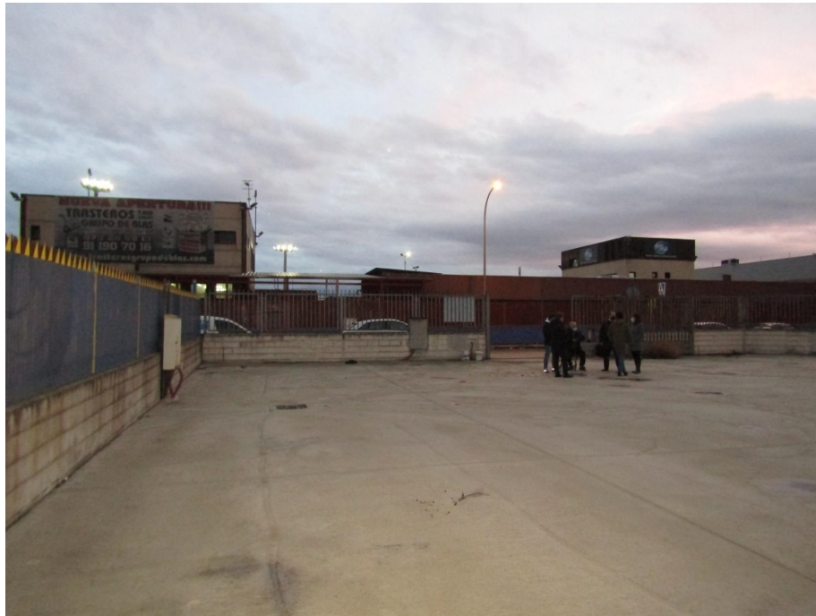
Vista de la entrada del emplazamiento.
