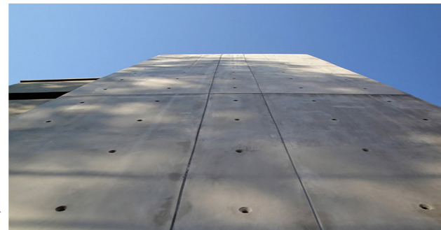
Imagen del muro de hormigón armado del "Edificio Puerta" desde abajo.
