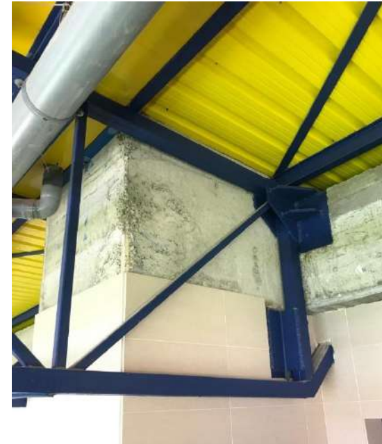
Fig. 67. Anclaje cubierta metálica a pilar.
