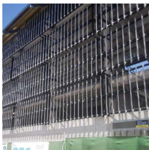
Fig. 62. Anclajes para el gres porcelánico.
