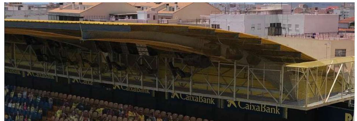
Fig. 71. Cubierta grada Sur.
