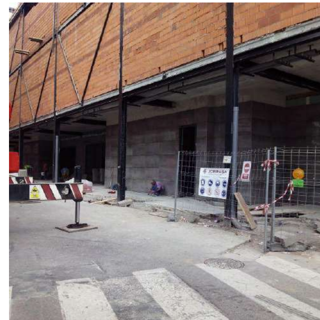
Fig. 56. Construcción de los pilares y vigas metálicas en la ampliación de tribuna
