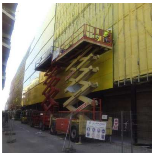
Fig. 58. Colocación paneles de gres.
