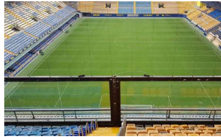
Fig. 85. Grada visitante vista desde el interior.
