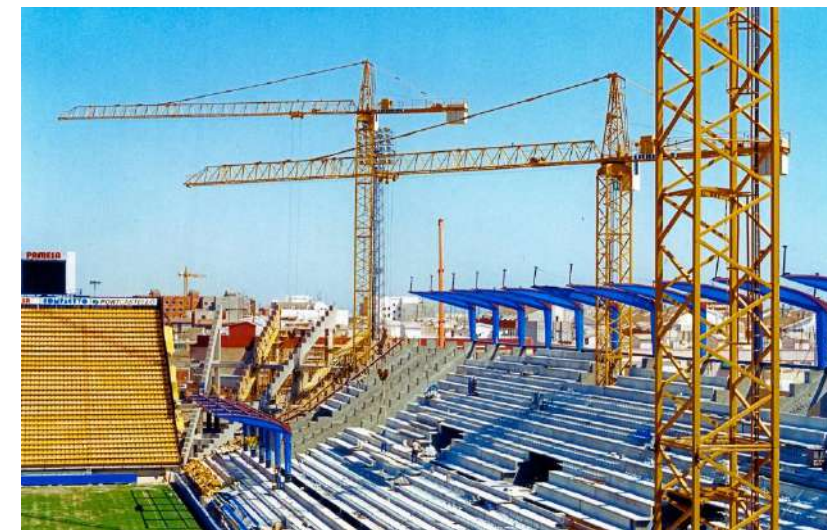
Fig. 49. Obras ampliación grada de Preferencia.
