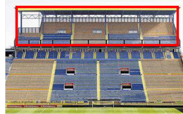
Fig. 30. Ampliación grada visitante.
