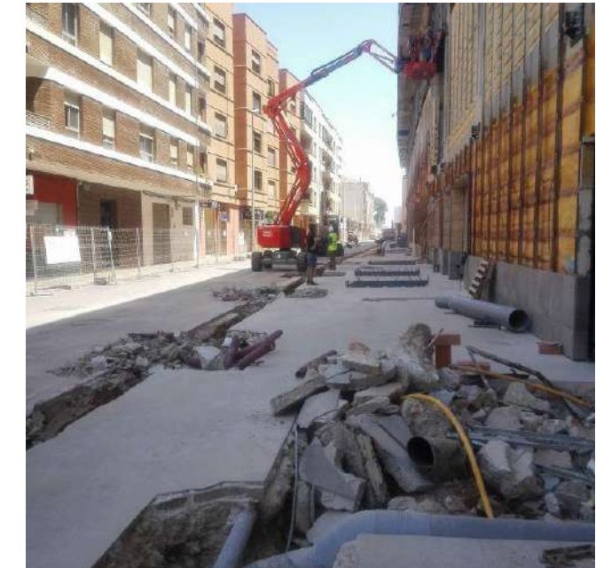
Fig. 57. Cimientos para pilares metálicos de la ampliación de tribuna.
