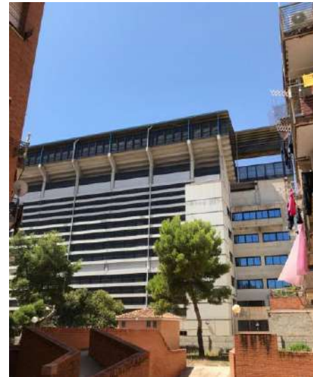
Fig. 54. Nueva fachada grada Norte.
