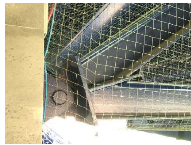
Fig. 80. Anclaje inferior Casals gros tribuna.
