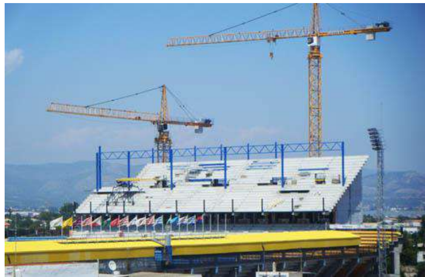
Fig. 53. Obras de ampliación en la grada norte.
