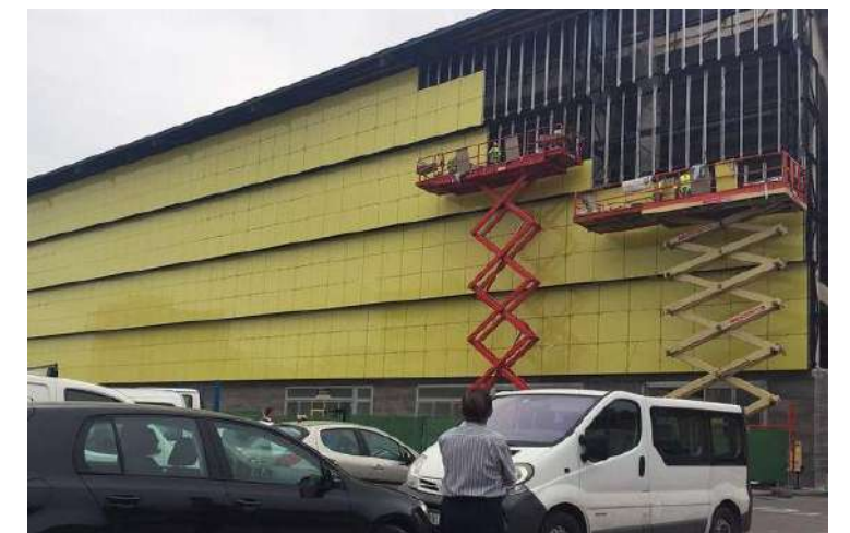
Fig. 74. Colocación paneles gres porcelánico.
