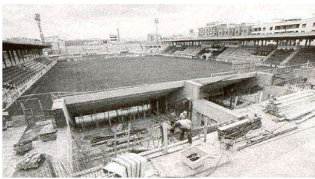
Fig. 45. Construcción de la nueva grada Sur.
