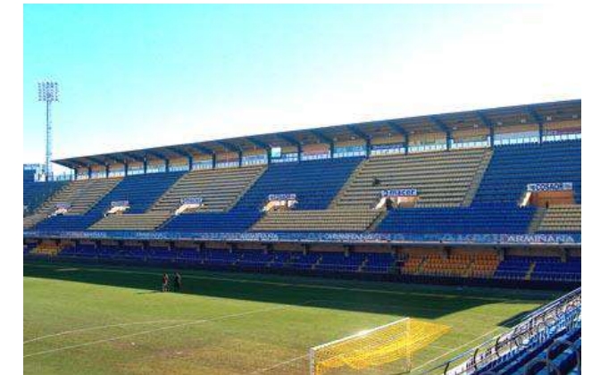
Fig. 52. Nuevas filas techadas en la grada de Preferencia.
