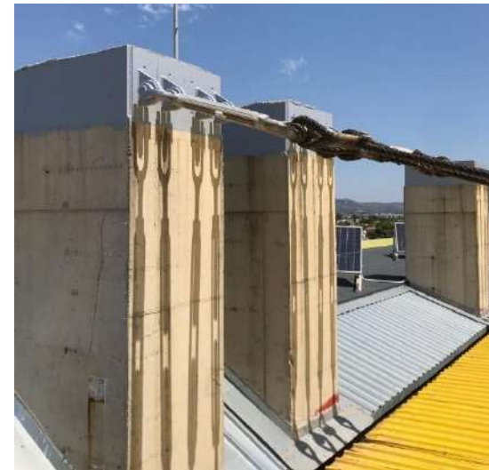
Fig. 69. Tirantes articulados a pilar.
