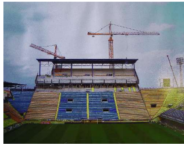
Fig. 87. Obras grada visitante y nuevos palcos fondo norte.
