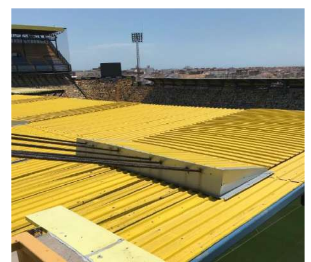
Fig. 70. Tirantes articulados celosía metálica.
