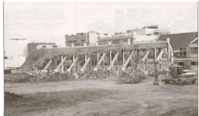
Fig. 44. Derribo grada Sur.
