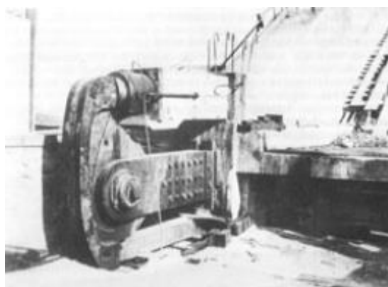
Ilustración 57 Sistema de anclaje del puente de Saale.
