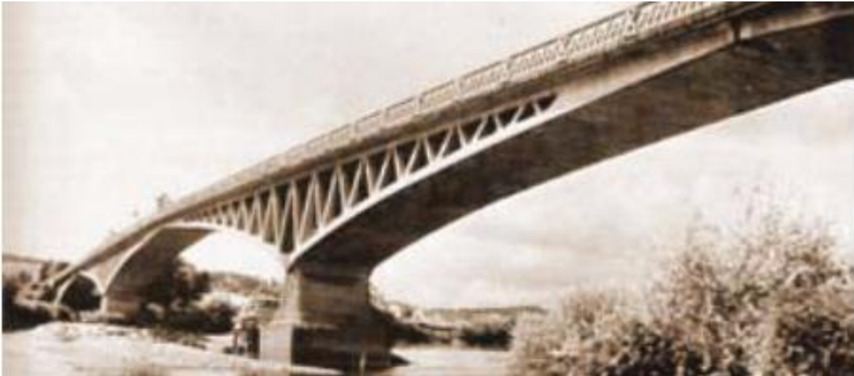
Ilustración 71 Puente de Le Veudre
