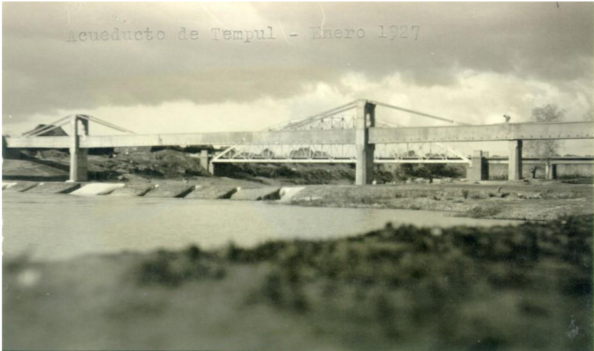
Ilustración 76 Acueducto de Tempul. Enero 1927. Fuente: http://www.cehopu.cedex.es/
