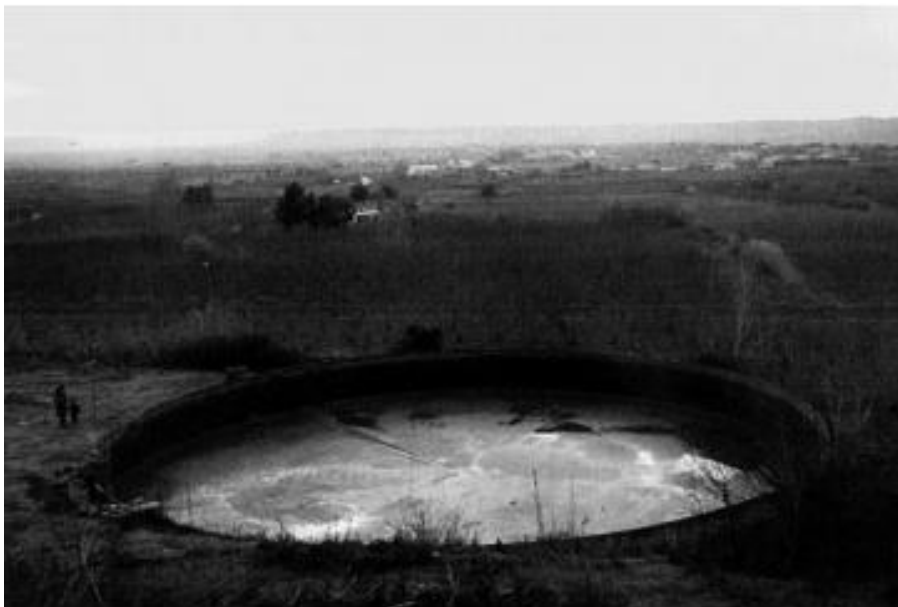
Ilustración 4 Depósito de Puigverd contruido por Frances Macià i Llussà, con el sistema Monier.
