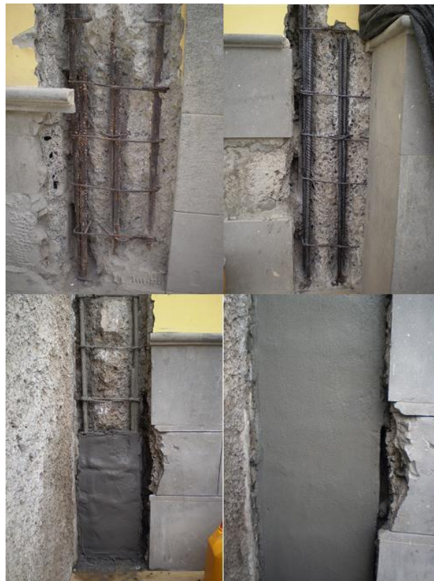
Foto nº 8 – Fases reparación de pilar con mortero. Fuente: www.construccionelasplamas.es
