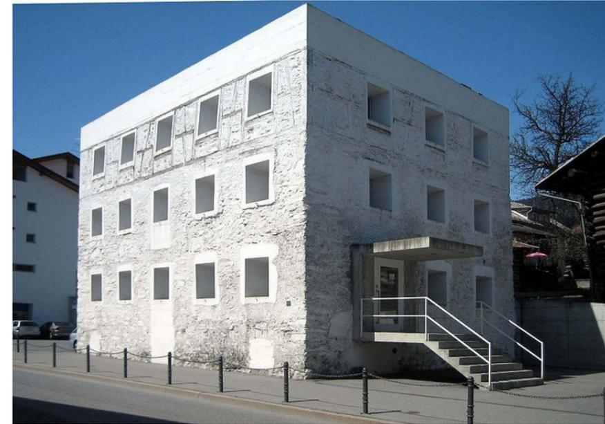
La actuación en el edificio preexistente fuera de ordenación es de vaciado y conservación de la fachada, a la cual se le elimina el acabado actual para sacar la esencia del material, en este caso ladrillo y dejar los elementos constructivos vistos. Posteriormente se pinta de blanco.
