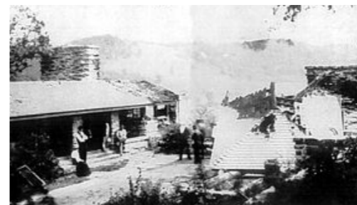
Figura 7. Casa Taliesin I tras el incendio
