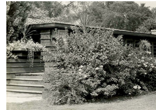
Figura 42. Foto en la que se aprecia la construcción mediante tablas y listones
