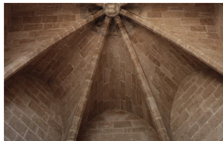
Figura 27: Fotografía de una bóvedas de crucería.
