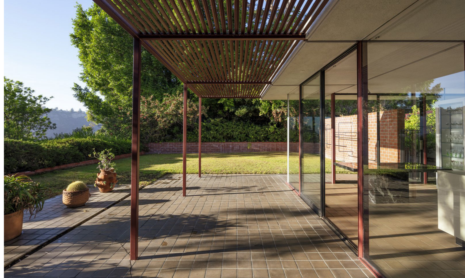
Figura 75. Foto del patio lateral y las vigas de acero que sostienen el techo de la casa mientras crean una cubierta enrejada. Fuente: https://www.dwell.com/article/case-study-house-16-craig-ellwood-273f59b6/6605453863944613888
