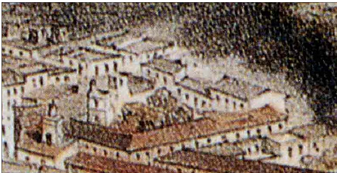
Detalle del palacio en la vista de A. Guesdon (hacia 1858)
