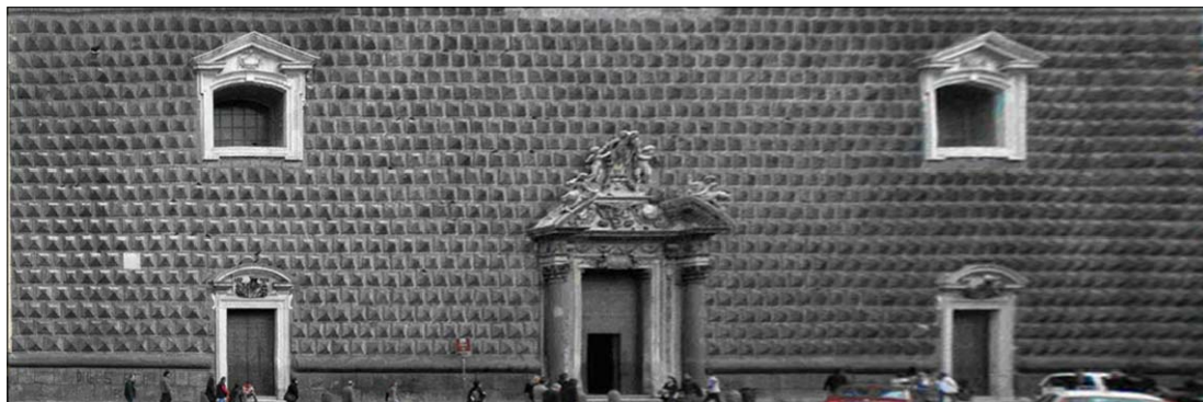
Palacio Sanseverino en Nápoles (1470) transformado en iglesia del Gesù Nuovo
