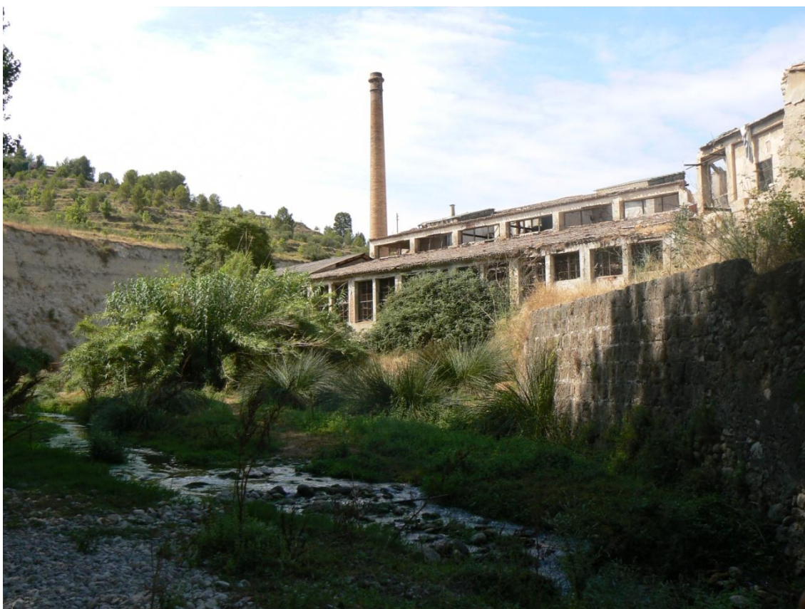
Fig.2 Imatge que mostra l'aspecte degradat de molts dels trams del riu a aquesta zona.
