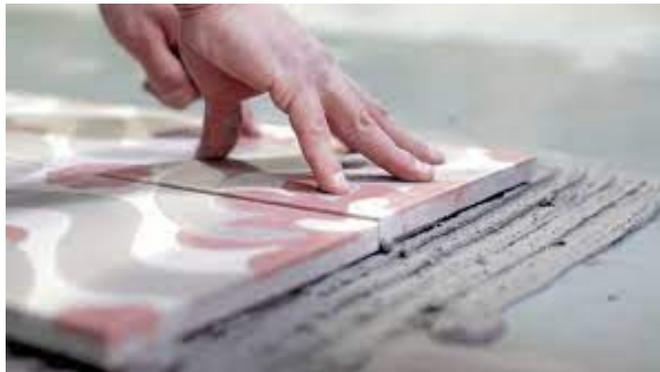
*Imagen 8: Colocación de la baldosa hidráulica*
