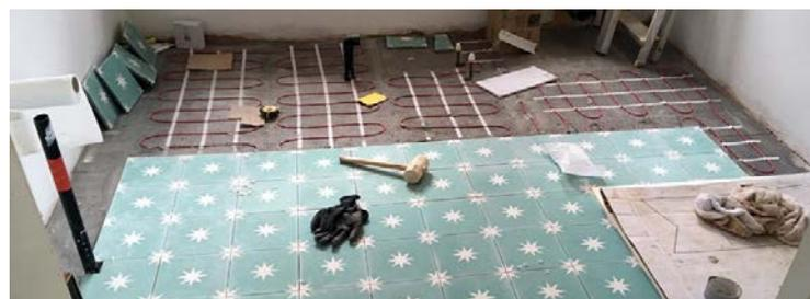
Imagen 10. Aplicación de la baldosa sobre suelo radiante
