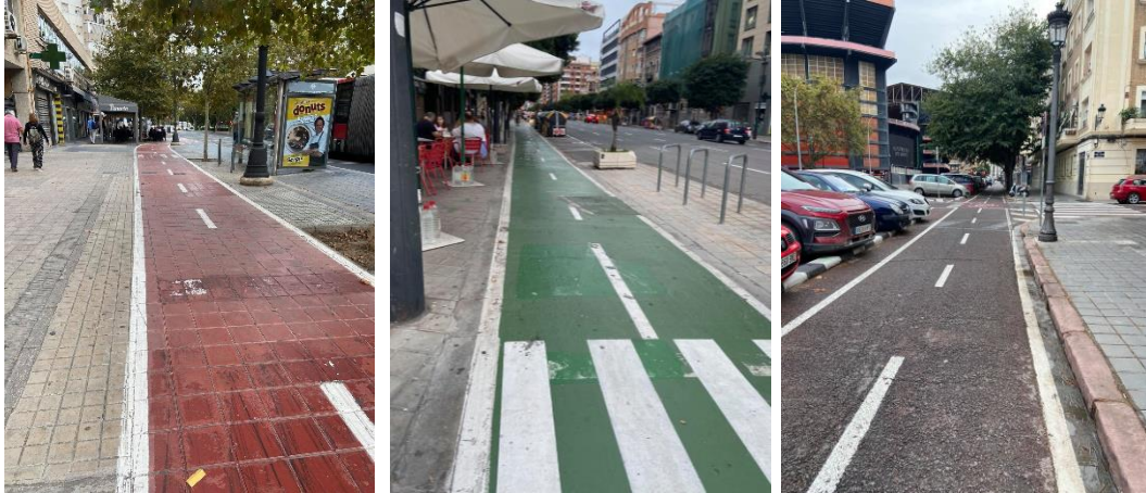
Figura 8-8. Ejemplo de pavimentos con estado ADECUADO. Fuente: Tomadas insitu
