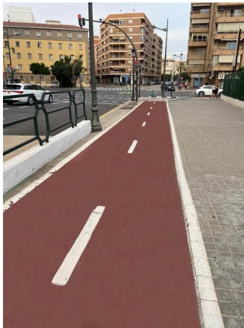
Figura 8-13. Reposición de losa de hormigón en la calle Dr. Gómez Ferrer. Fuente: Elaboración propia
