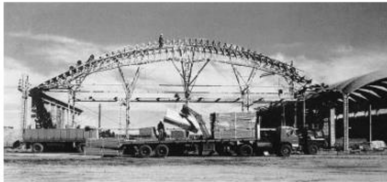
Figura 13. Equipo de trabajo realizando prueba de carga. Fuente: Jiménez 1996
