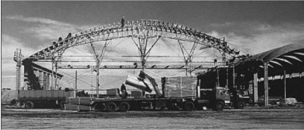
Figura 12. Boveda gausa en proceso de construcción Fuente: The double-curvature masonry vaults of Eladio Dieste R. Pereschi & D. Theodossopoulos
