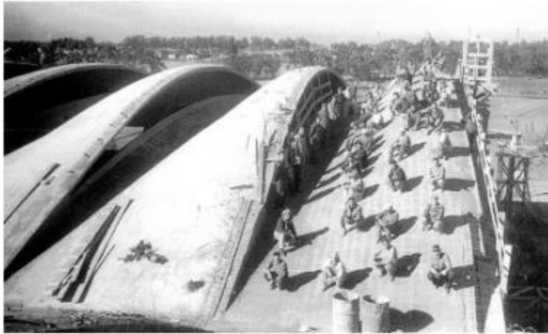
Figura 12. Cimbra de lámina de doble curvatura discontinua. Fuente: Jiménez 1996
