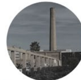
1 Chimenea antigua fabrica "El Prado".
