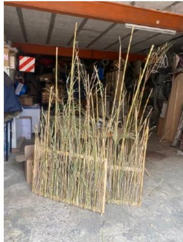
**Fig.33:** Construcción y colocación de las cañas al marco de madera
