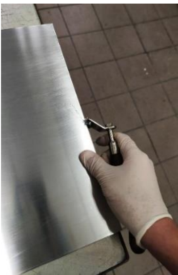
Fig. 55, Proceso de biselado de los bordes de la plancha de zinc , Álvaro Ulloa, UPV, Valencia, 2022.
