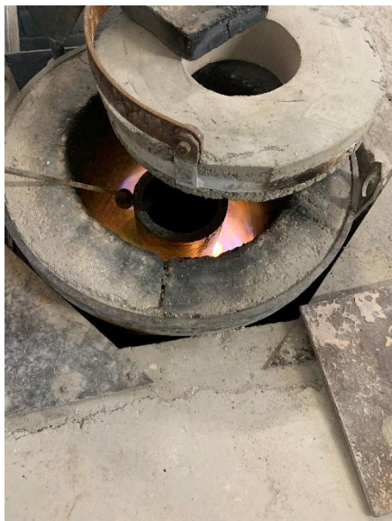
Fig. 51 Encendido del horno con soplete, con crisol vacío en el interior.
