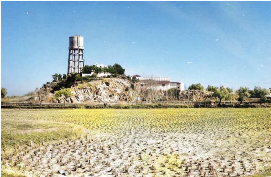
Figure 1: Muntanyeta dels Sants elevated reservoir
