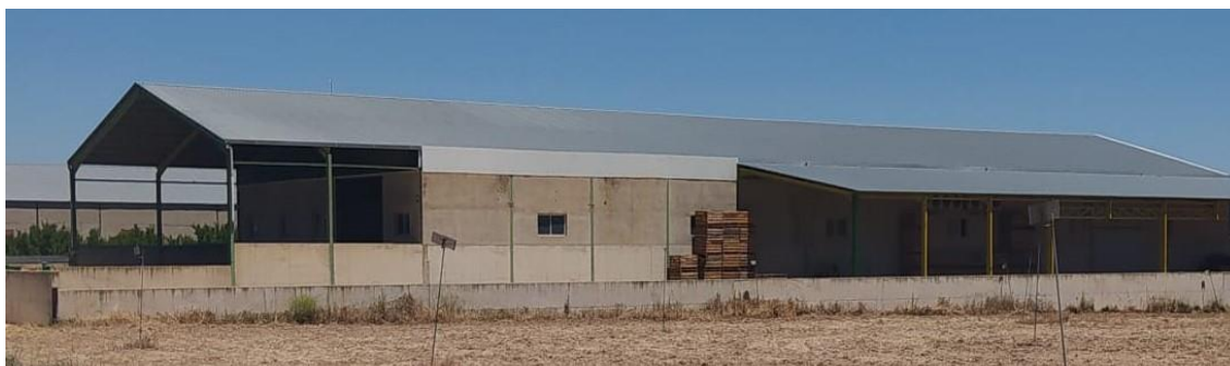
Ilustración 1. Nave industrial CEBOLLAS TARAMAN
