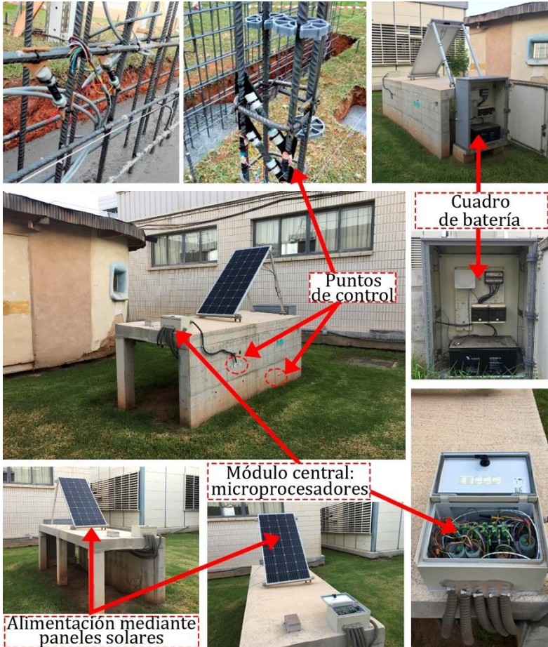
Figura 5. 9- Estructura a escala ubicada en la UPV. Prototipo del sistema sensor original. Elaboración propia.
