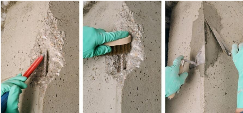
Figura 4. 26- Reparación mediante parcheado 572 .
