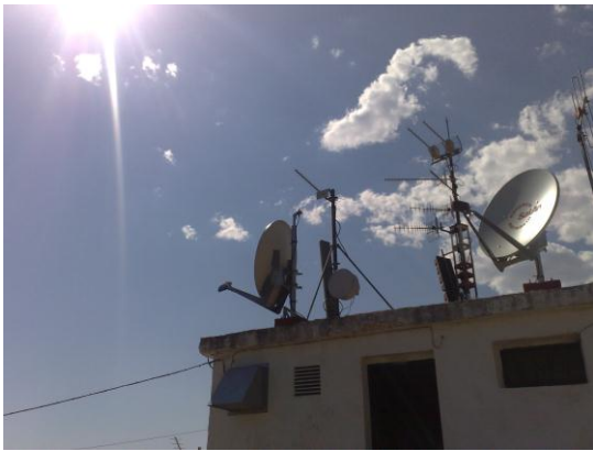
Figura 26: Exterior de la caseta del centro
