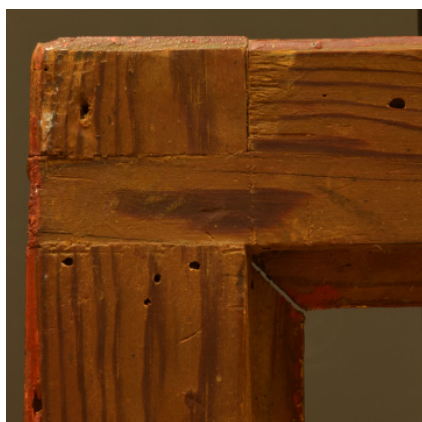
Figura 46. Fotografía de la esquina superior izquierda (tipo de anclaje y veteado).
