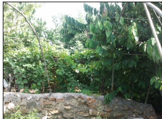
Foto 4: Invernadero en proceso de construcción. El muro de piedras funciona como acumulador de calor.
