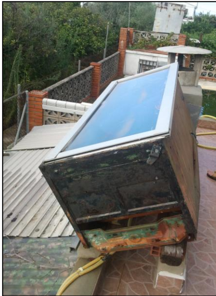
Foto 1: Calentador de agua fabricado con materiales reciclados
