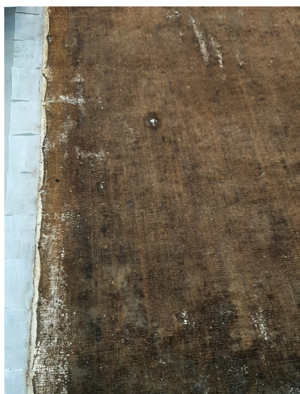
Figura 53. Fotografía de detalle del resultado de la eliminación del entelado.
