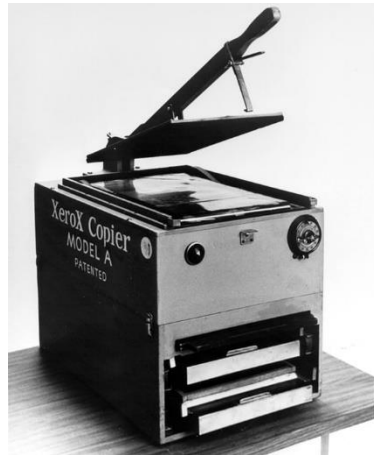
Imatge 5. Copiadora "Xerox" model A. Primer model comercialitzat d'impressora multifunció. 1950.
