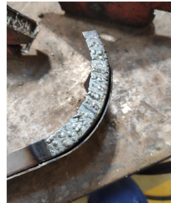
Fig.43. Diego Vidal. Soldado y rellenado de las curvas de los perfiles.
