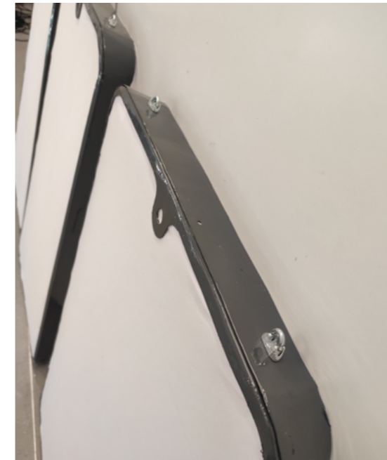
Fig.51. Diego Vidal. Colocación de los soportes.
