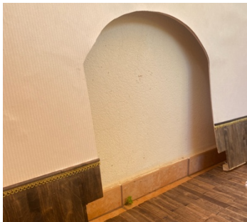
Imagen 16: Proceso de construcción de las paredes.
