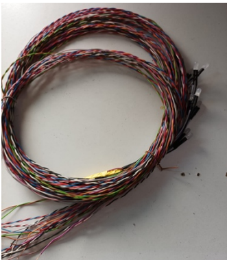
Imagen 27: Proceso de construcción del circuito eléctrico.
