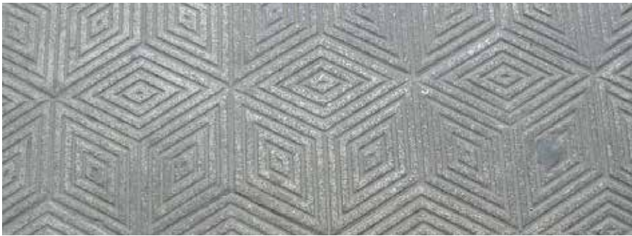
2.6 Pavimento con geometría de rombos.
