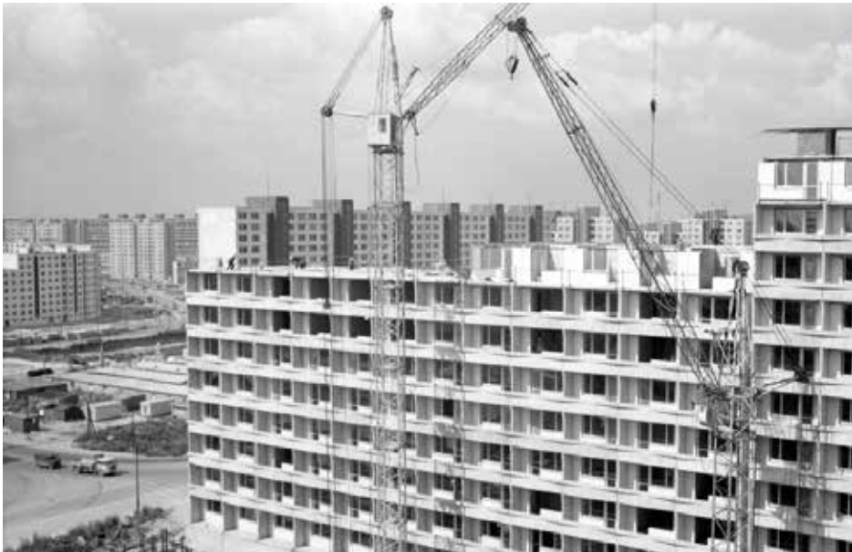
4.8 Plattenbau en construcción en el barrio Petržalka, Bratislava, Eslovaquia, 1980.
