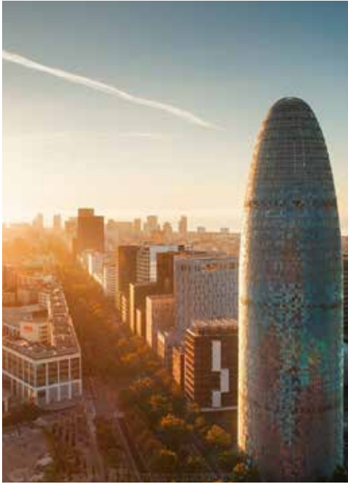
3.18 Torre Glòries, Barcelona.
