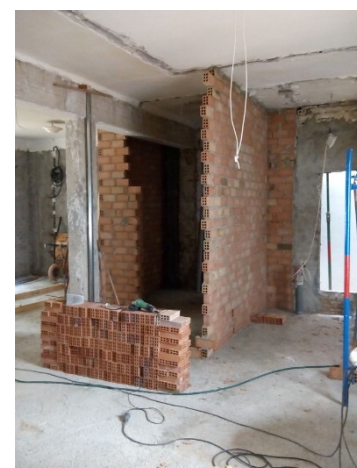
Imagen 12. Disposición de la perflería o ladrillos de los nuevos tabiques. Fuente: https://acortar.link/5BgP7Z y https://acortar.link/mnPnXI
