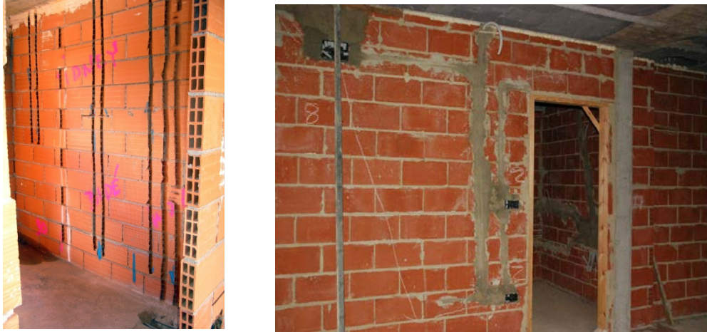
Imagen 13. Tabiquería con replanteo de instalaciones y rozas. Fuente: https://acortar.link/DOXth8 y https://acortar.link/qieFOz
