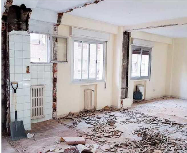
Imagen 11. Derribo de los elementos indicados en los planos. Fuente: https://brillastur.com/reformas/
