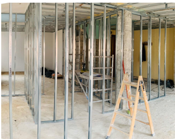
Imagen 12. Disposición de la perflería o ladrillos de los nuevos tabiques. Fuente: https://acortar.link/5BgP7Z y https://acortar.link/mnPnXI
