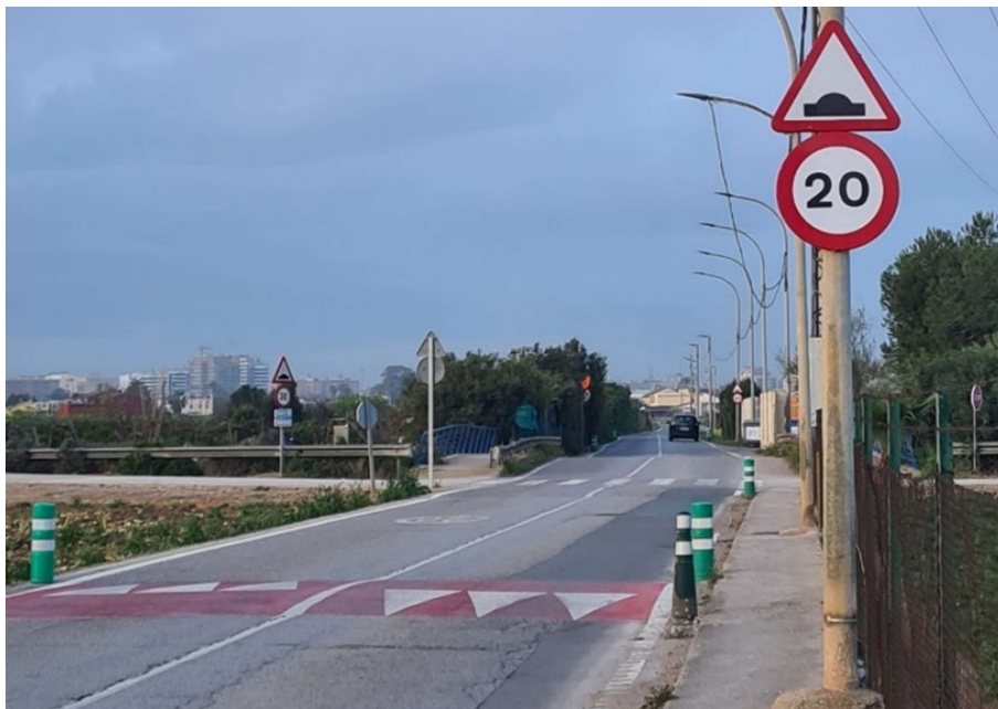
Imagen 75. Reductor de velocidad de pavimento
