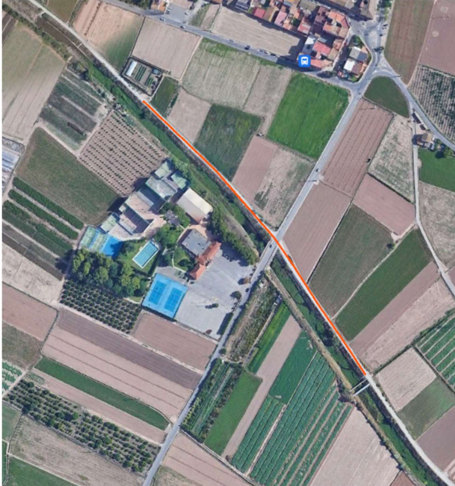
Imagen 30. Trazado de la carretera del Camino de Carpesa-Moncada
