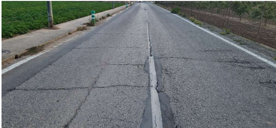
Imagen 56. Fisuras transversales.
