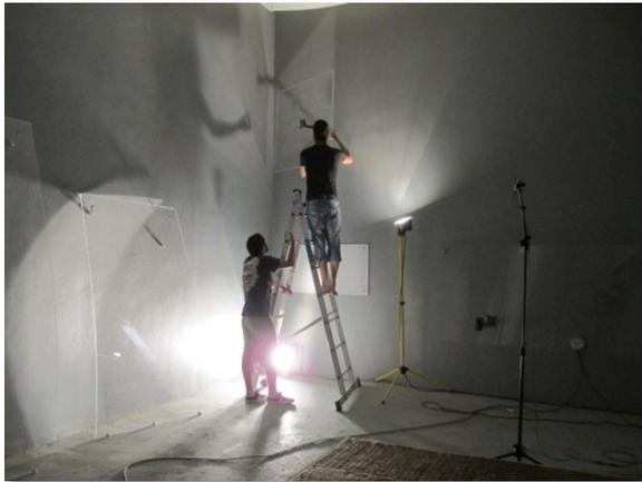
**Fotografía 15: Colocación de los difusores definitivos de paredes y suelo.**
