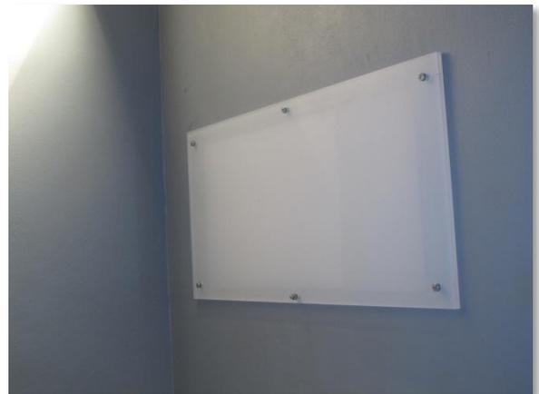
**Fotografía 2: Sellado del retorno con metacrilato de 15 mm.**
