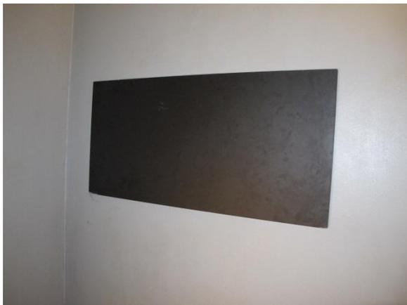
**Fotografía 1: Sellado del retorno con tablero de madera DM**
