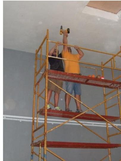
**Fotografía 12: Colocando los cáncamos del techo con pernos.**
