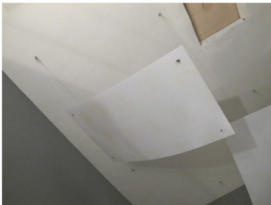
**Fotografía 13: Ejemplo de un panel difusor suspendido del techo.**
