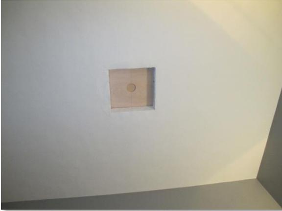
**Fotografía 3: Sellado del orificio del techo con tablero de madera**
