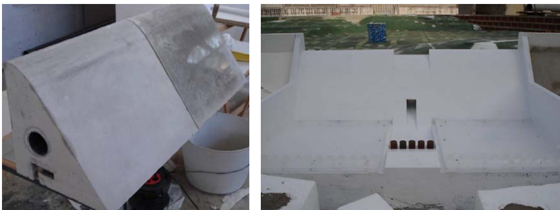
Figura 8. Construcción del cuerpo de presa
