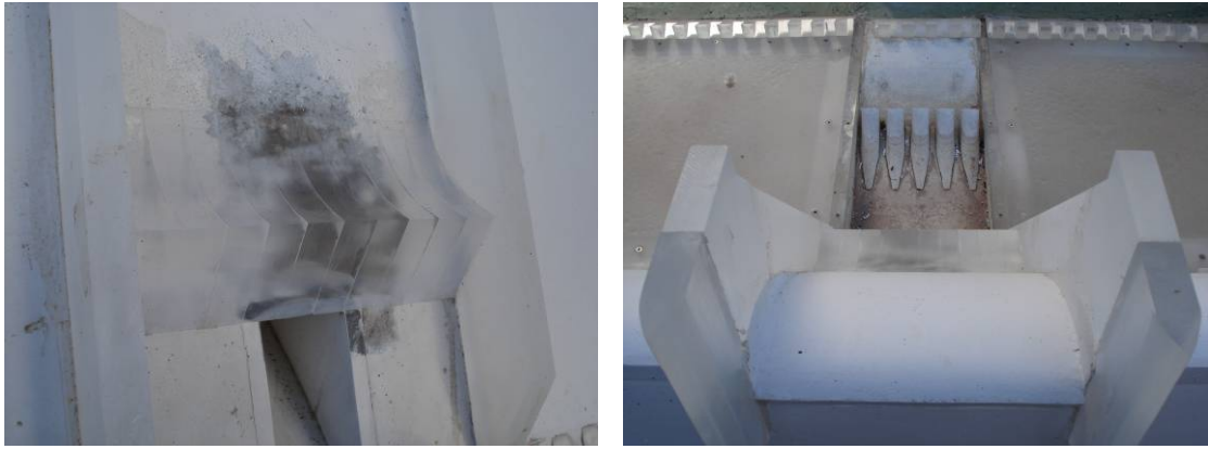
Figura 14. Detalle deflector ocupando el ancho del vano central
