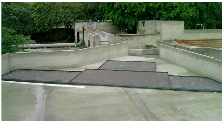
Figura 4. Colocación de las placas de acero
