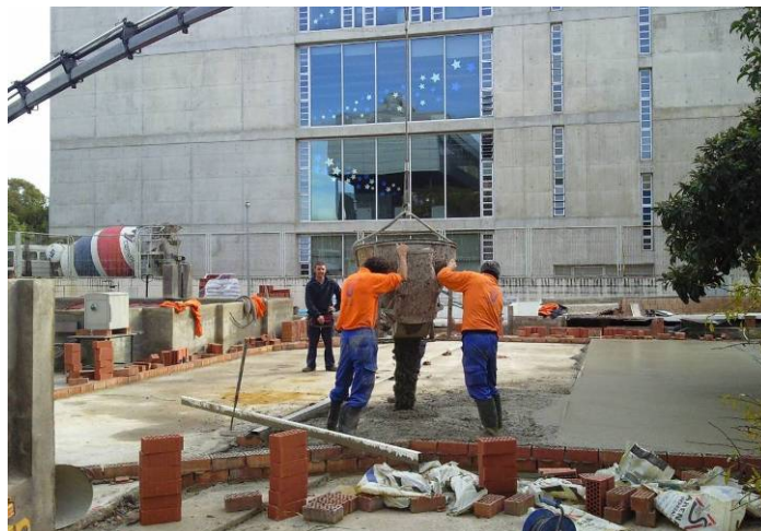
Figura 3. Construcción de la infraestructura
