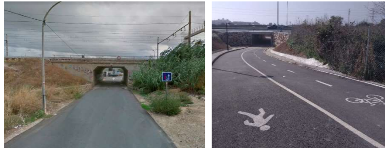
Figura 7 Izq. Acceso Este. Túnel bajo las vías del tren Dcha. Acceso peatonal Sur. Túnel bajo la carretera.
