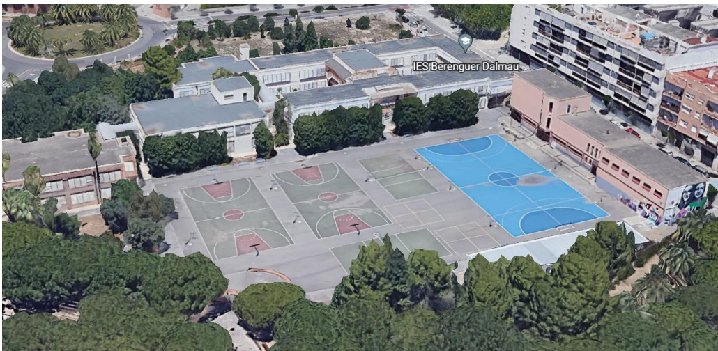
Ilustración 2. Emplazamiento de la instalación.
