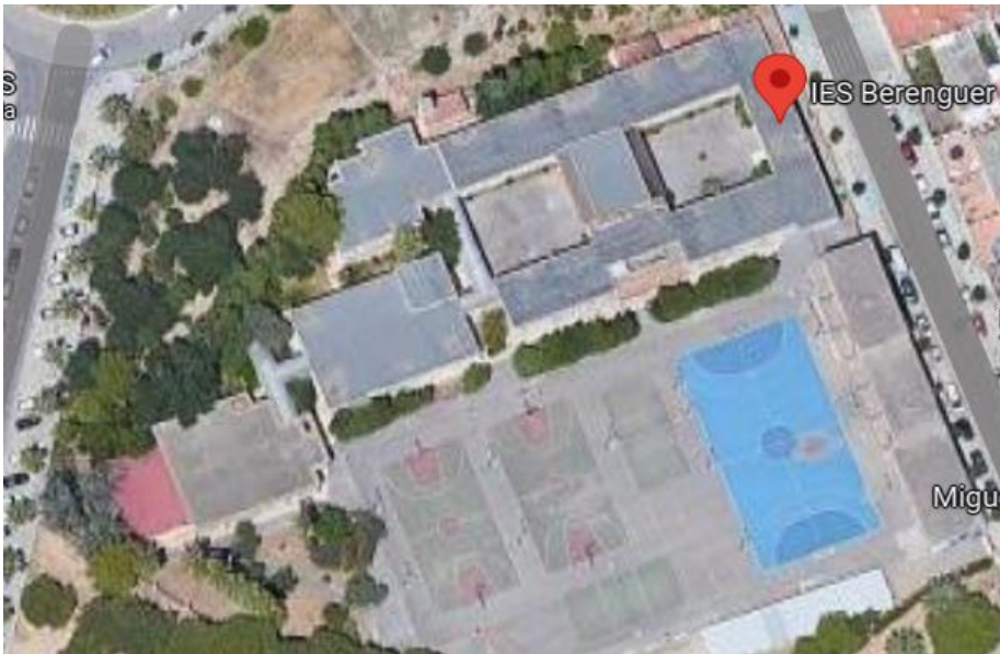
Ilustración 1. Emplazamiento de la instalación.
