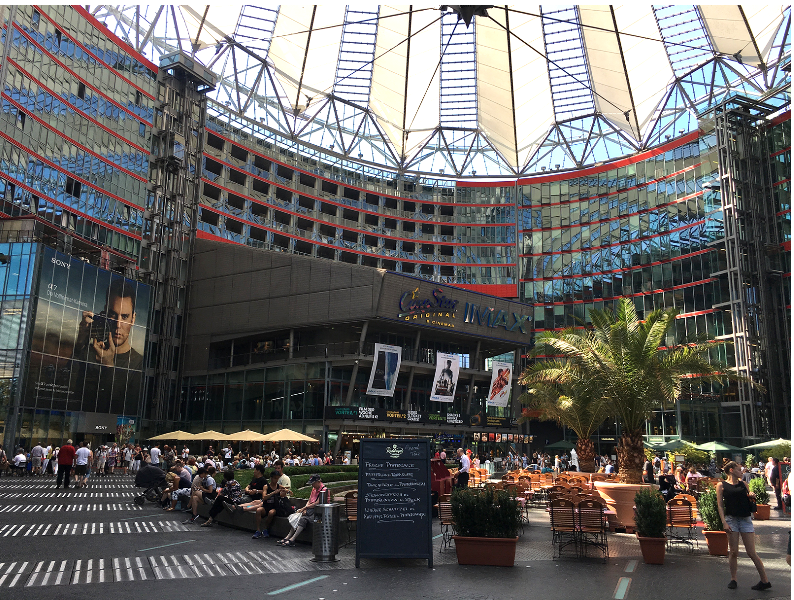
Figura 06. Sony Center. Es un complejo comercial en Berlín en Postdamer Platz. El espacio más representativo es el foro central, una plaza cubierta por una cúpula compuesta por amplias terrazas y una fuente. Este lugar está contenido entre los edificios que componen el proyecto, pero su carácter es abierto y permeable, por lo que junto con el comercio y las funciones de las terrazas representa un lugar de carácter colectivo característico de la ciudad. Fuente: elaboración propia.
