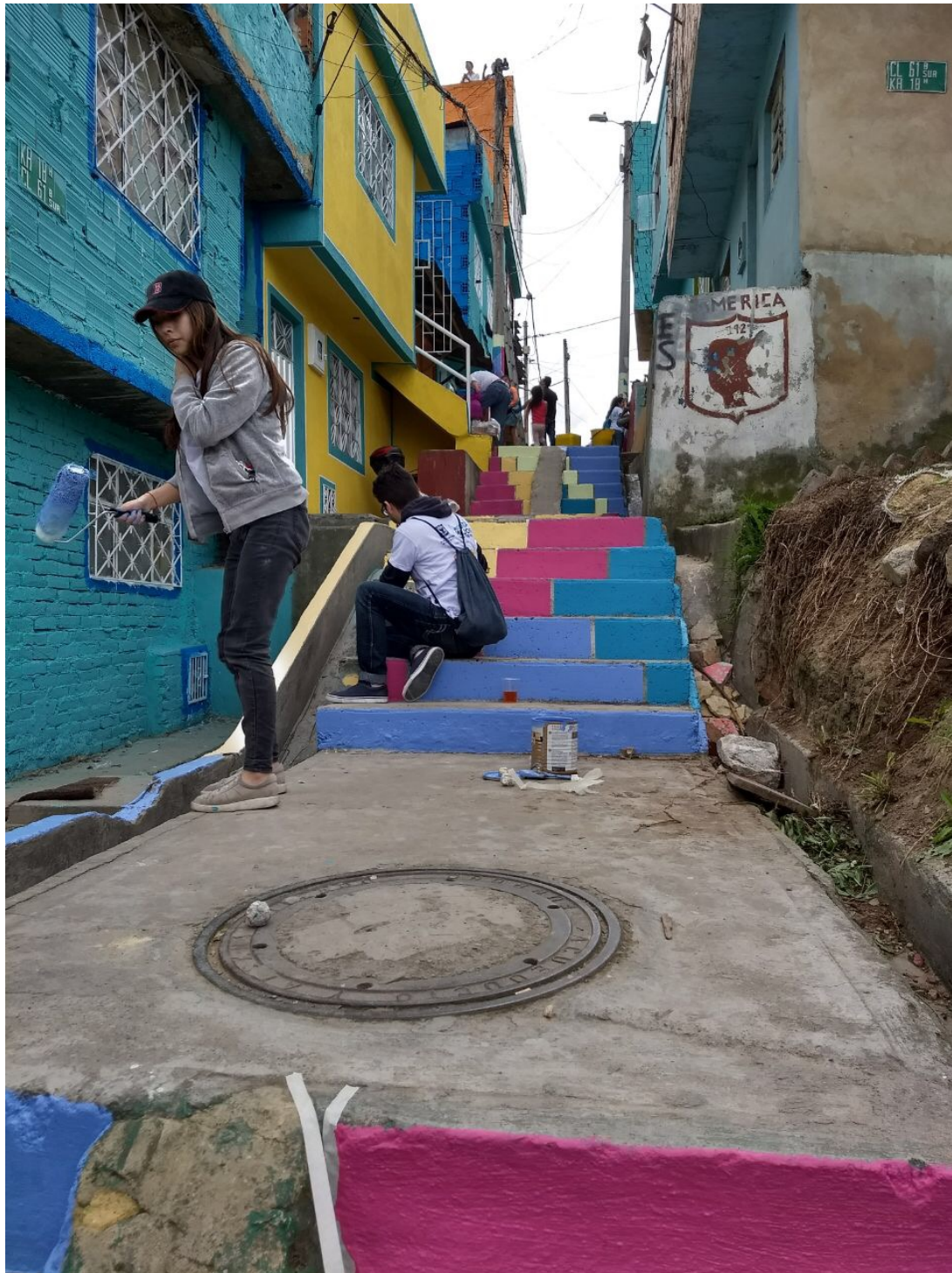
Figura 45. Mejoramiento Barrial en Ciudad Bolívar. Este sector de Bogotá se caracteriza por su origen como asentamiento informal, altos índices de violencia, inseguridad, pobreza y degradación ambiental. Recientemente, la Administración Distrital ha promovido junto con la Secretaría del Hábitat programas de mejoramiento. Se han pintado las fachadas de las viviendas y tramos de escaleras de acceso a los barrios. Esta iniciativa se ha materializado con el trabajo conjunto entre residentes, la academia, la Administración Distrital y voluntarios en las distintas fases, desde el diseño hasta su ejecución. Fuente: elaboración propia.
