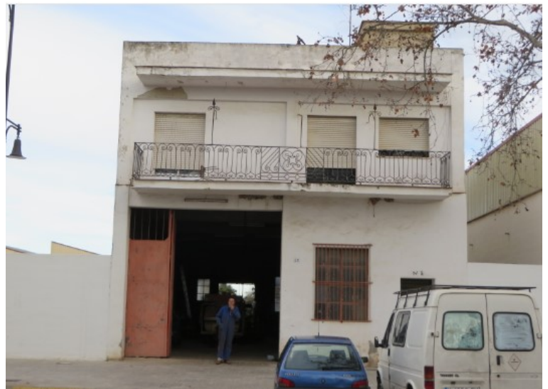
Figura 18: Vista frontal del edificio. Fuente: Google Maps
